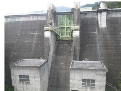
放流設備の改修(塗装、水密ゴム交換)
