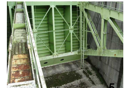
放流設備の改修(塗装、水密ゴム交換)
