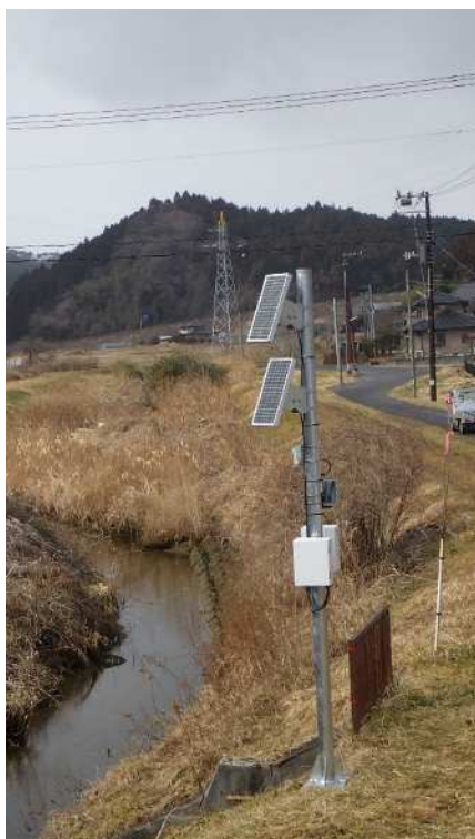
監視カメラ 設置状況（新川）
