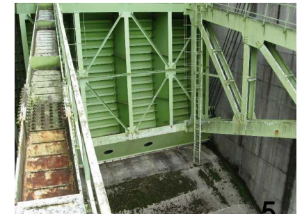
放流設備の改修(塗装、水密ゴム交換)
