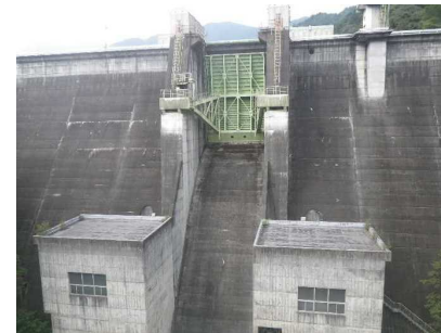
放流設備の改修(塗装、水密ゴム交換)
