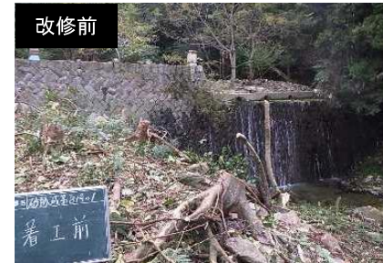
砂防における老朽化した施設(堰堤)の改修
