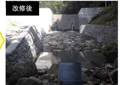
砂防における老朽化した施設(堰堤)の改修
