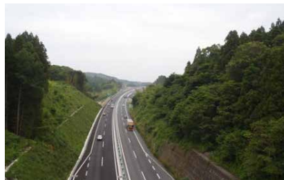
▲仙台松島道路4車線化
