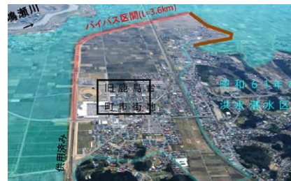
▲国道346号鹿島台バイパス供用開始区間
