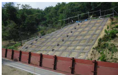
▲【23災5326号復旧状況】吹付法砕工
