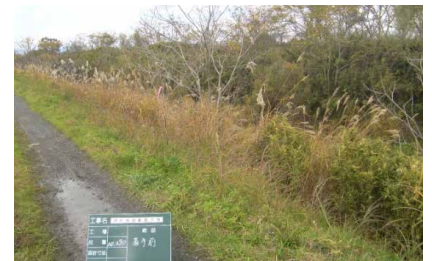
▲若柳狭窄部の伐採工(着手前)
