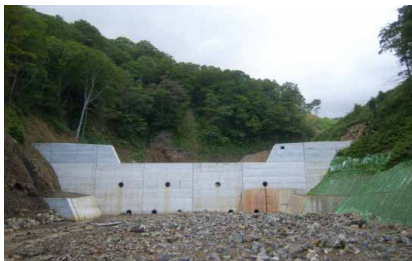
▲県耕英東1号砂防えん堤の完成
