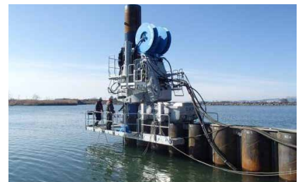
▲定川破堤部の鋼管矢板打設状況
