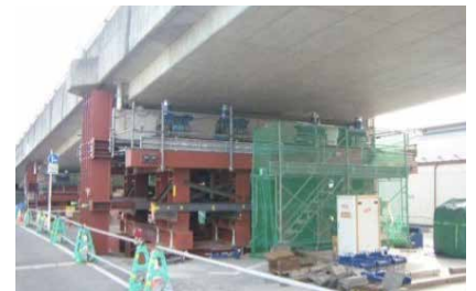
▲3径間に移動用支保工・ベントを設置
