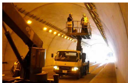
▲トンネル詳細点検の実施状況
