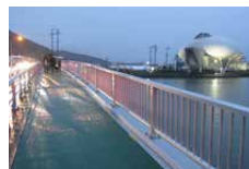
▲内海橋歩道橋復旧後
