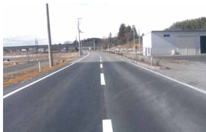
▲有賀道路災害((一)油島栗駒線)復旧後
