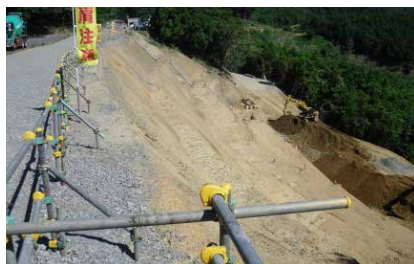
▲【23災5554号復旧状況】補強土壁工
