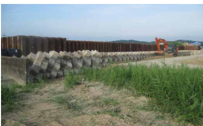
▲名鱒越流堤災害復旧工事完了
