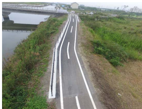
令和元(2019)年10月23日 完成
