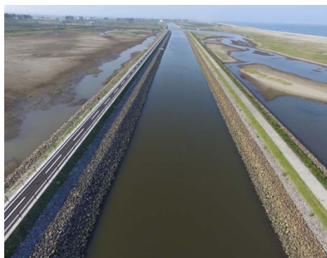
令和元(2019)年10月23日 完成
