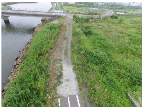
北貞山運河 仙台市若林区藤塚地内
