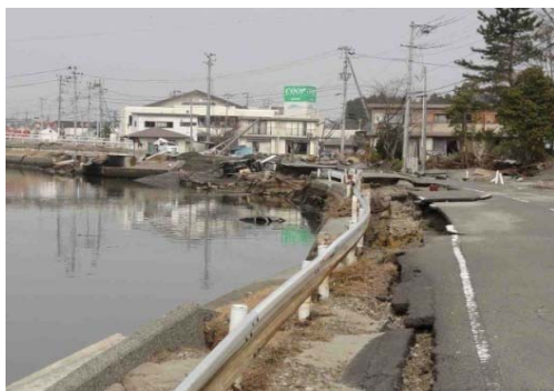
旧砂押川 (橋本橋上流から下流を望む)
