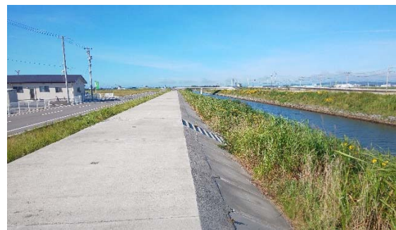
令和元(2019)年8月30日 完成
