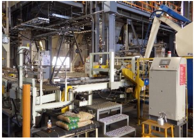
ペレット製造工場
