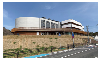
写真:鳴瀬桜華小学校(東松島市)
