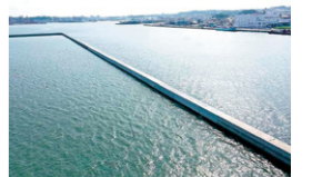
写真:塩釜漁港東防波堤改築工事完成
