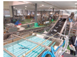
写真:復旧した水産加工設備
