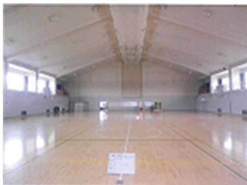
講堂天井改修（着手前）
