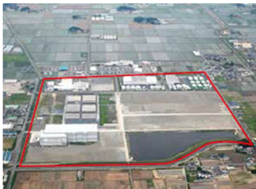
貸付金を活用して造成した工業用地（亙理中央地区）
