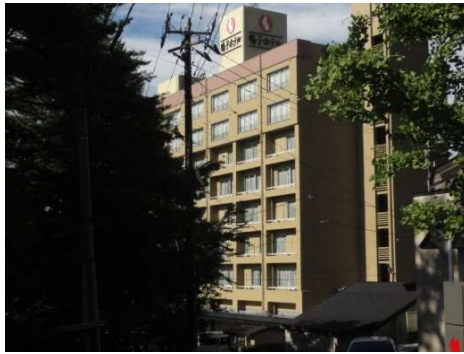
耐震改修完了（鳴子ホテル）
