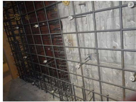
改修工事の施工状況
