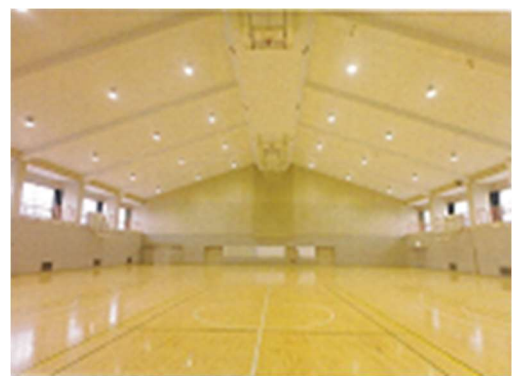
講堂天井改修（完成）
