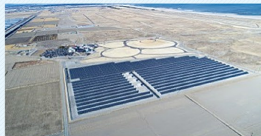
巨理・山元第2地区太陽光発電所
