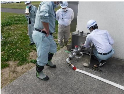
減圧弁の設置
