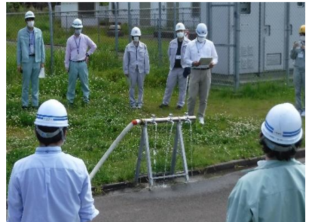
給水栓の設置
