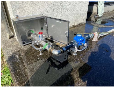
給水供給ユニットの設置
