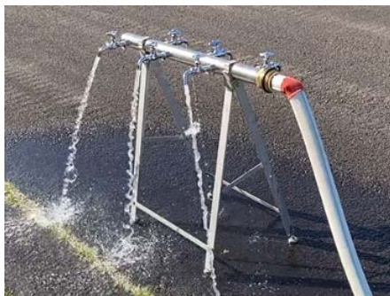
給水栓の設置
