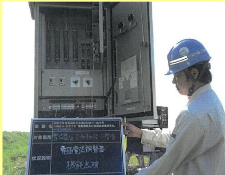
管路上の設備点検状況
