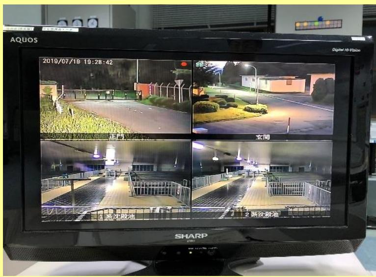
モニターによる監視状況
