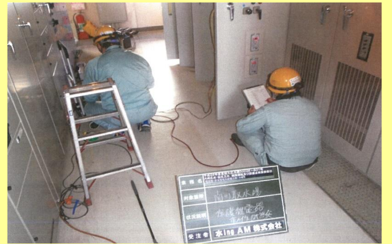
受変電設備の点検・補修
