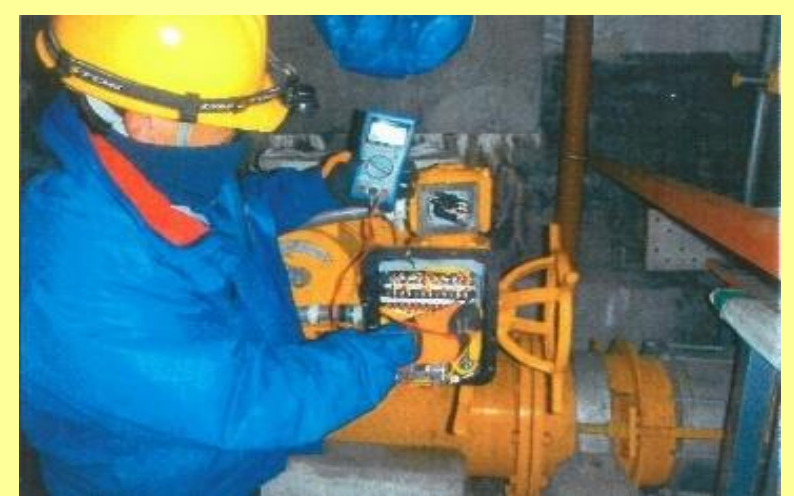
ろ過池表洗弁修繕
