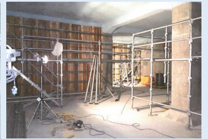
調整池の耐震化工事
