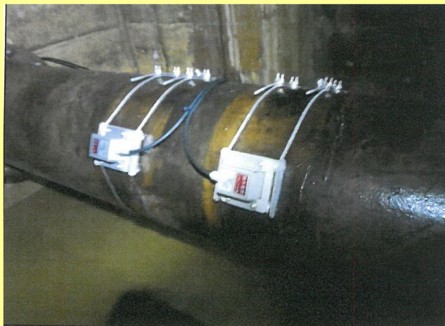
幹線流量計の更新状況
