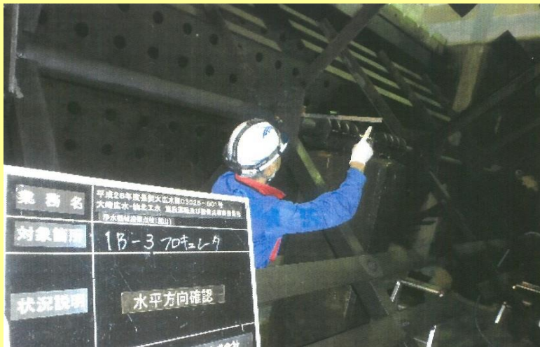
浄水機械設備の点検・補修
