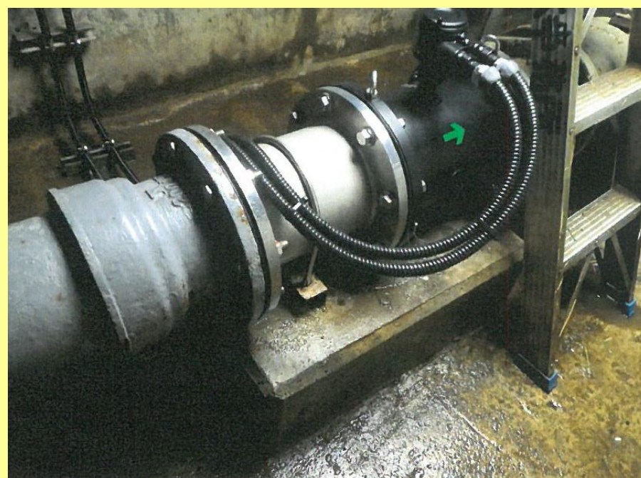
受水流量計の更新状況
