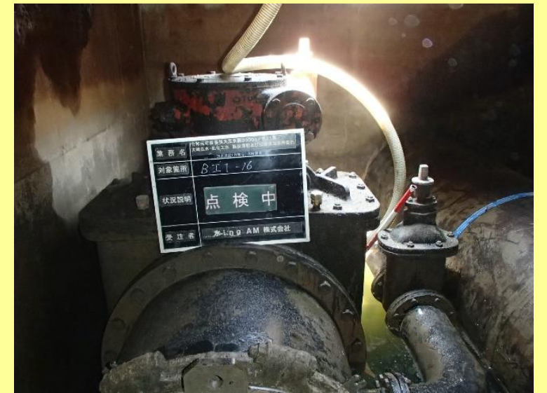
弁類点検状況
