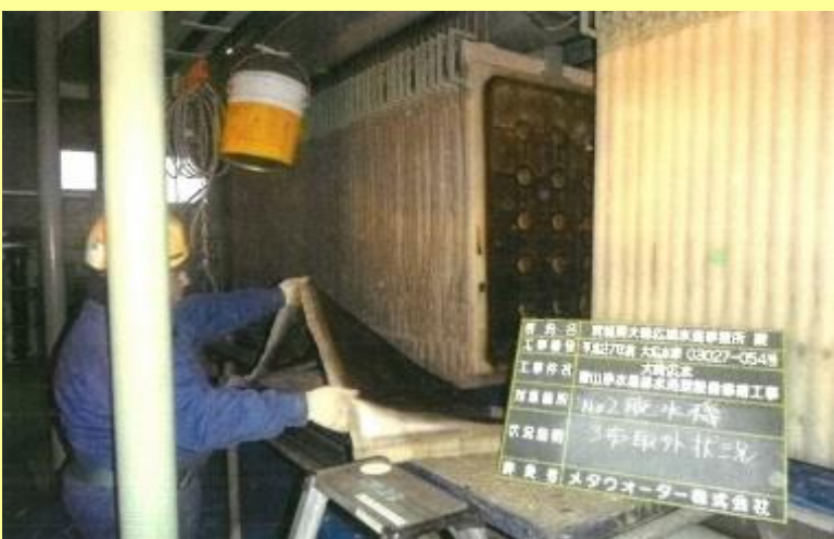
脱水機ろ布膜の修繕
