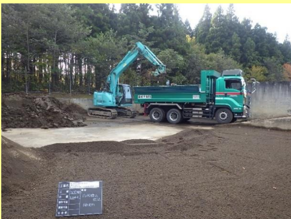
麓山浄水場天日乾燥床 における処理発生土搬出状況
