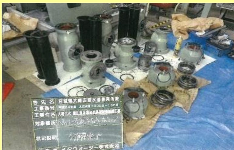
汚泥打込みポンプ修繕
