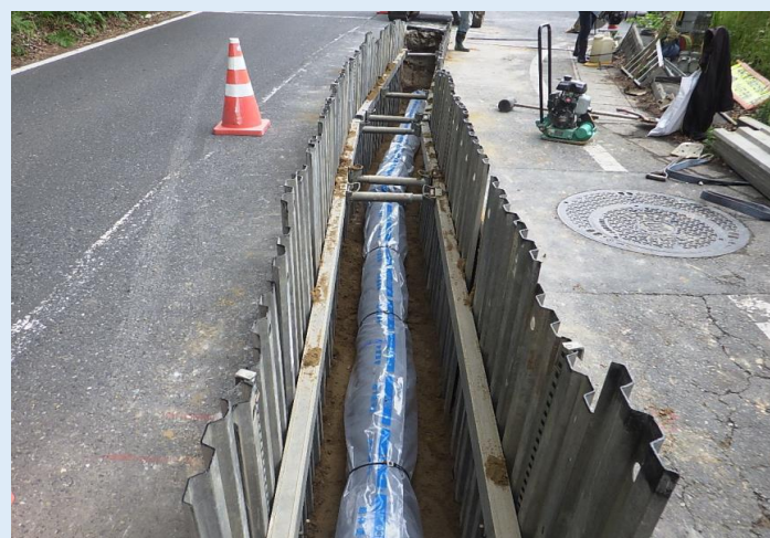
管路更新による耐震化工事
