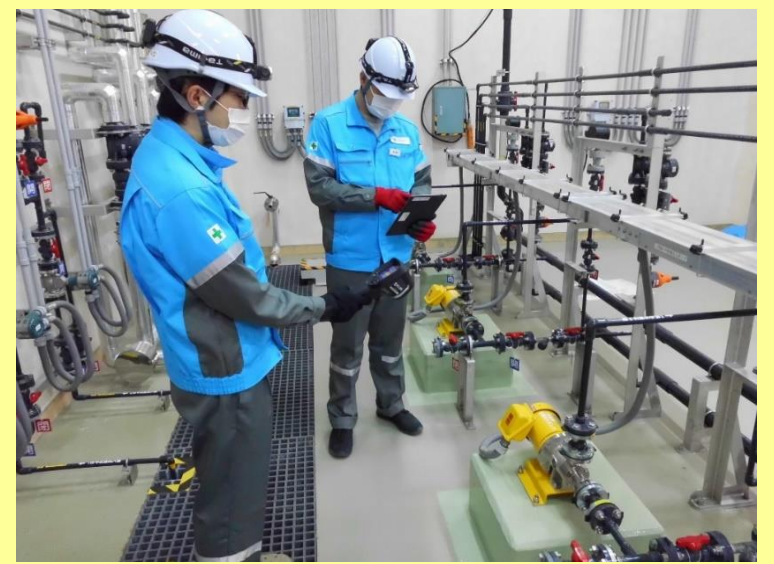
設備類の点検状況
