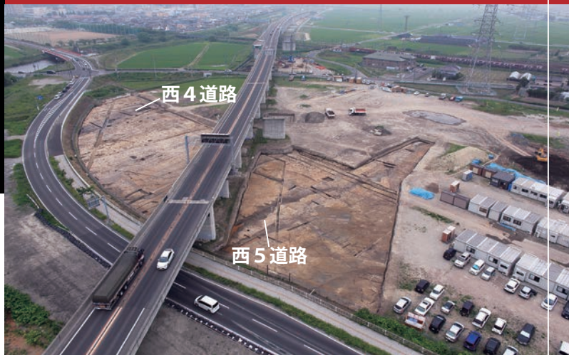
道路跡空撮 (M区北西から)
