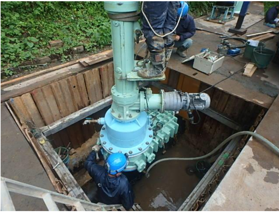
不断水分岐弁設置状況
