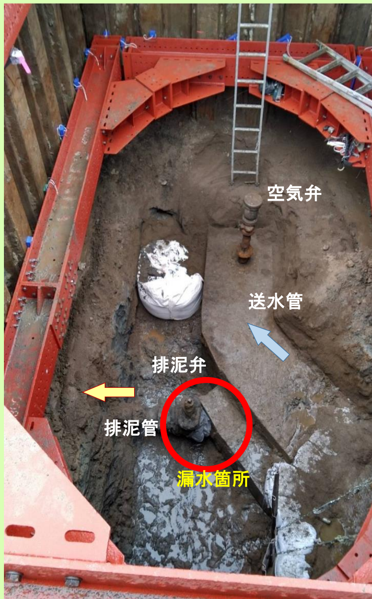
漏水復旧箇所の掘削状況
