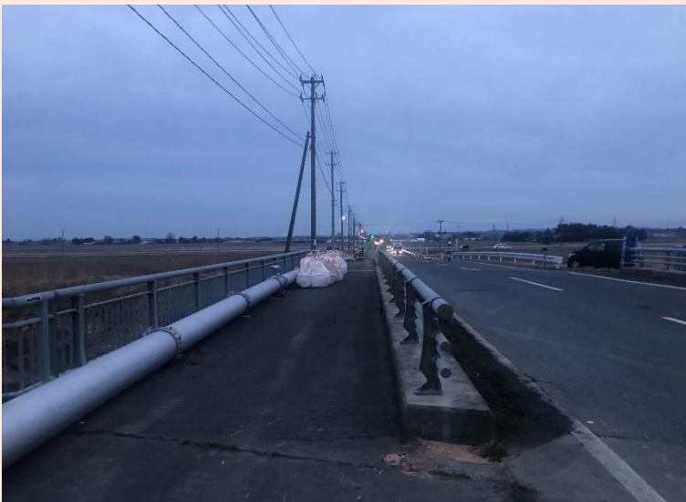
仮管設置状況(歩道路肩部)
