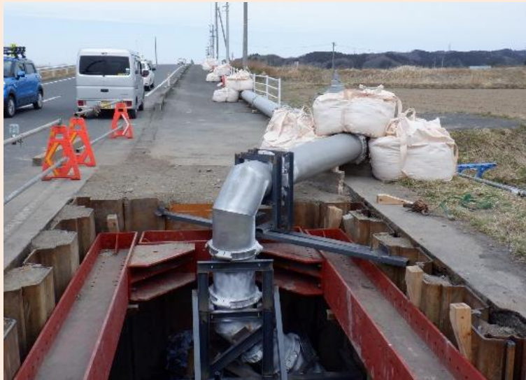
仮管設置状況(不断水分岐箇所)
