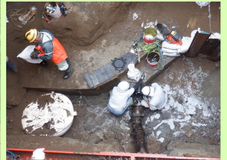
排泥弁撤去・フランジ蓋設置状況
