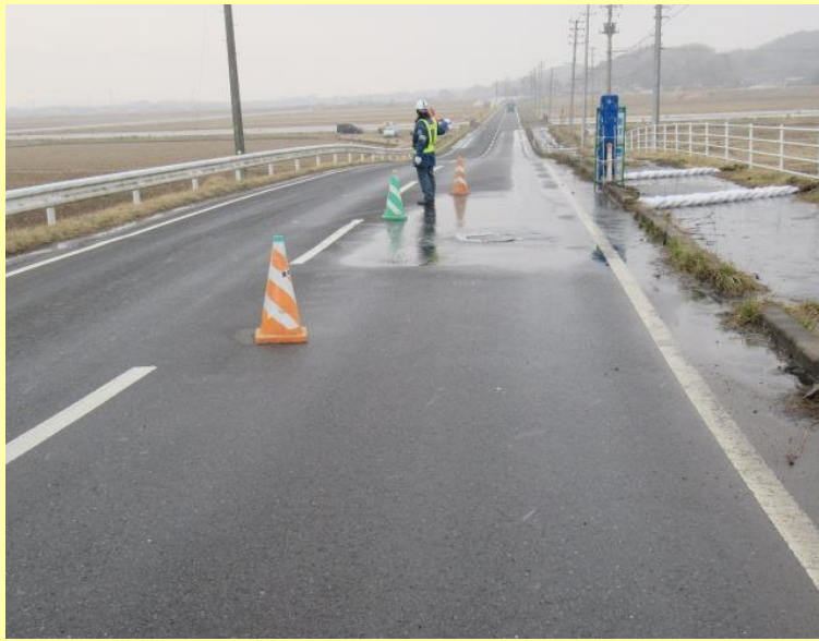
マンホールからの漏水状況及び市道通行規制状況
