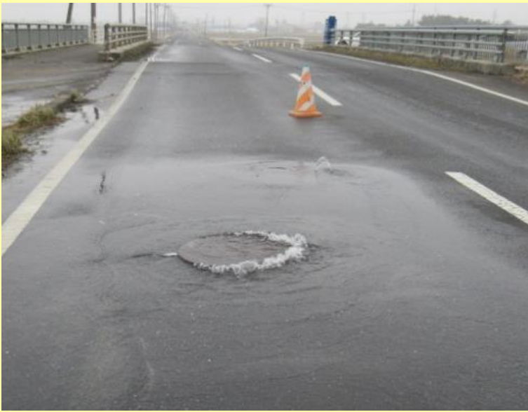
マンホールからの漏水状況及び市道通行規制状況
