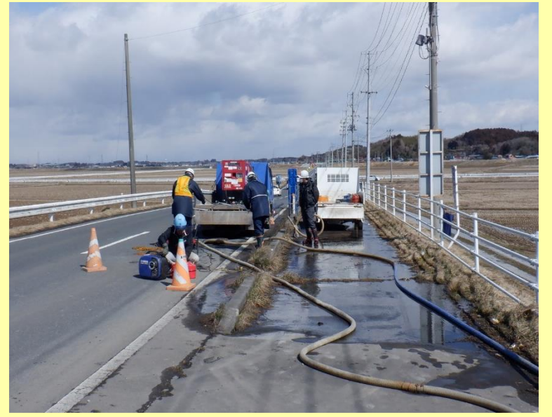
マンホールの水替状況
