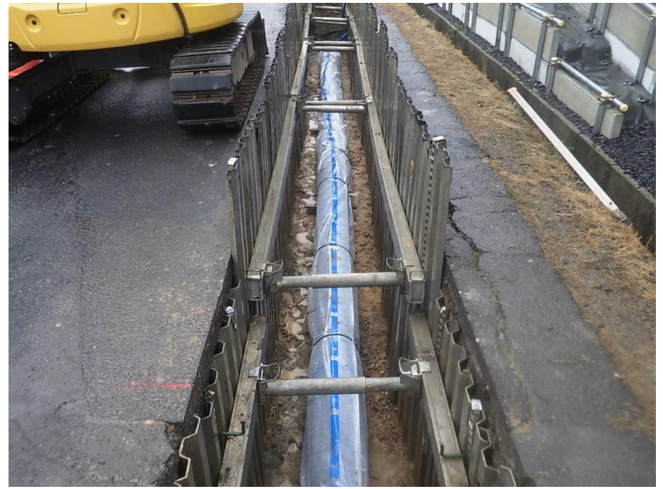
送水管布設完了状況
