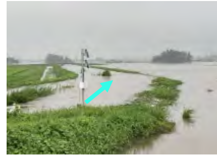
越水写真(神堂橋付近)
