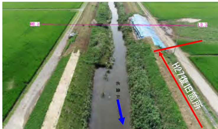
H27決壊箇所の状況(0.3k下流)
