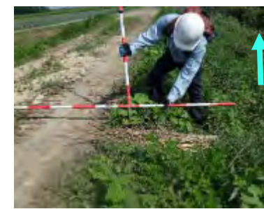
越水写真(痕跡)
