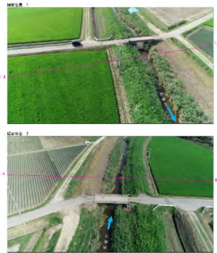
左岸に土砂堆積
