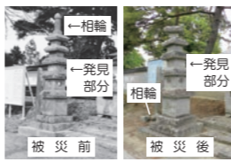
被災前と後の五重塔です。上層になるほど歪みが大きくなり、相輪は地面に落ちて壊れています。
