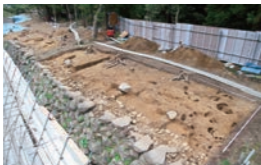
裏側に小さな石を詰めて固定しています。
