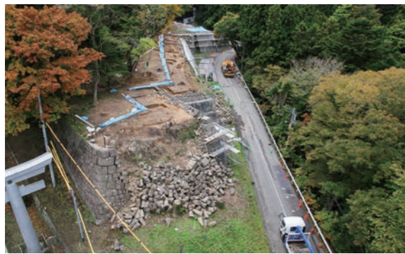
本丸北西石垣は、3カ所で崩落したほか、広い範囲で変形しました。
