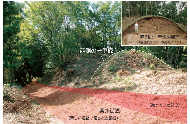
奥州街道は明治時代以降に新しい道路に造り直されたため、残っていたのは一部のみでした（北から）。
