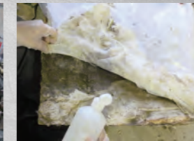
梱包材を除去し、薬剤を塗って表面が崩れないように強化します。
