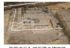
発見された礎石建の建物跡
