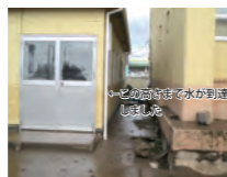
ふるさと館収蔵庫の被災状況
