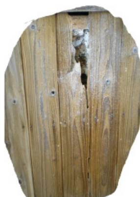
巣の外壁全容
