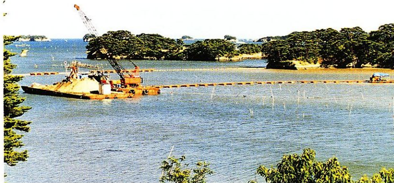
松島湾しゅんせつ工事
