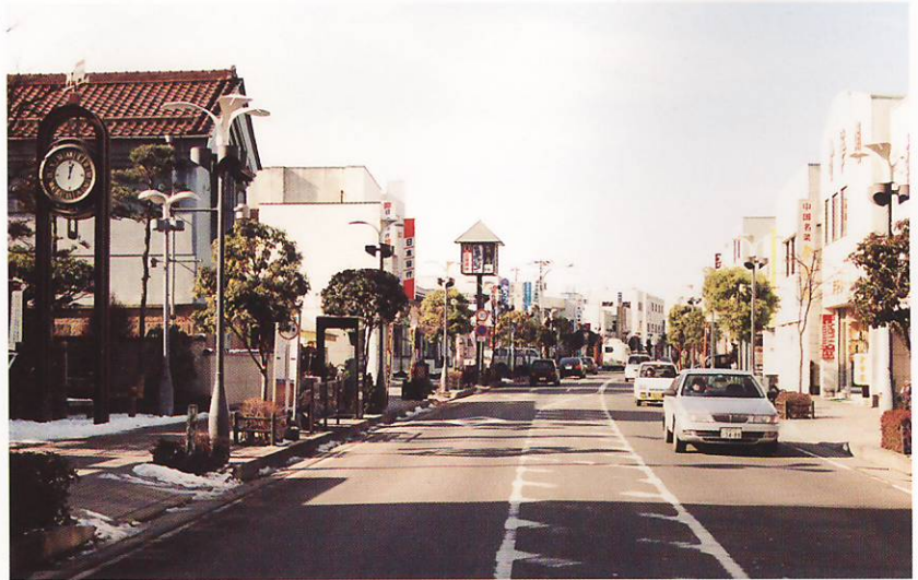
無電柱化したモール
