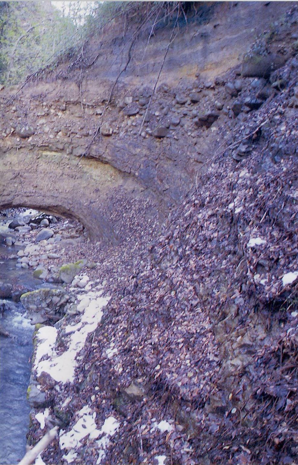
鍋割沢にかかる小原の土橋
