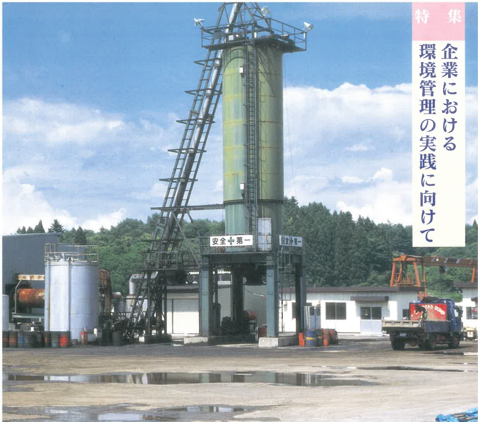
アスファルト再生工場
