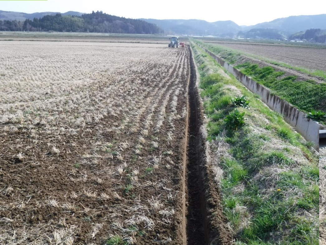
写真 額縁明渠の施工
