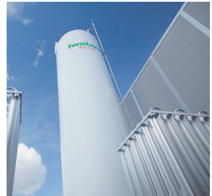
◀ 液化水素タンク
