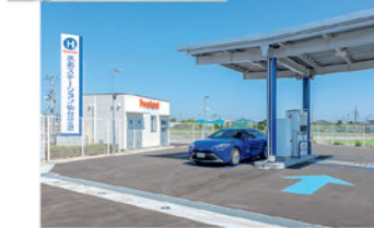
県内2基目の商用水素ステーション(岩沼市)
