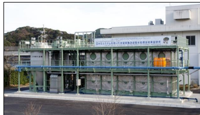
DHSシステムを用いた水量変動追従型水処理技術 実証研究 (H28:B-DASH)にて、水処理施設のダ ウンサイジングを実証研究中
