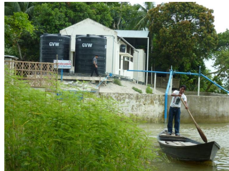
浄水プラント
