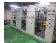
設備(資産の3割) 維持管理・更新工事
