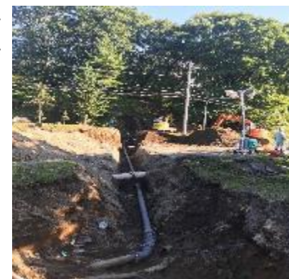
厚真町 新町浄水場導水管補修
