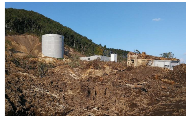
厚真町 富里浄水場・配水池 (土砂崩れ)
