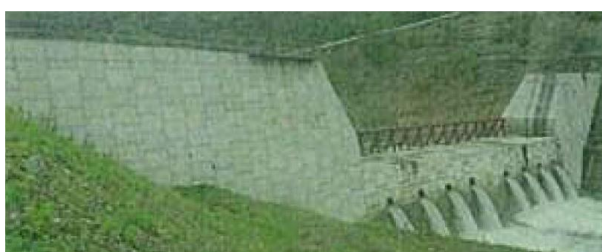
板川砂防堰堤の流木止 (現状の流木捕捉工)
