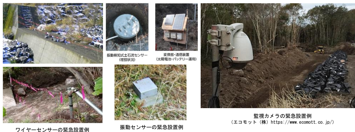
図 2-12 監視観測機器の緊急設置例
