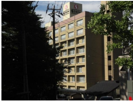
耐震改修完了（鳴子ホテル）
