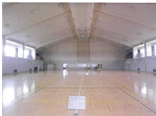
講堂天井改修（着手前）
