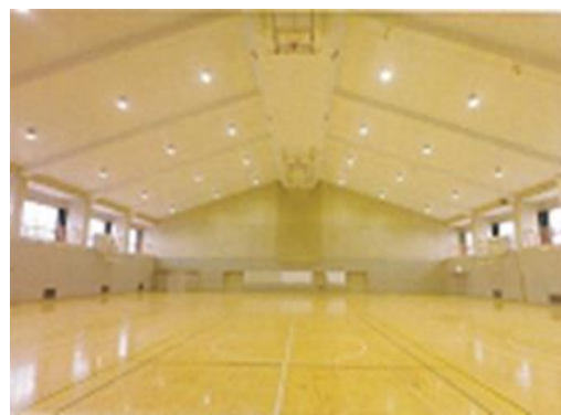
講堂天井改修（完成）
