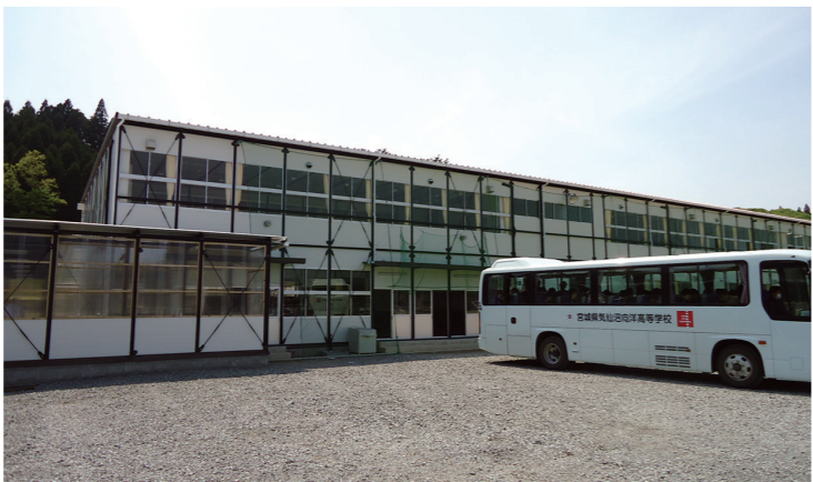
仮設校舎（気仙沼向洋高等学校）
