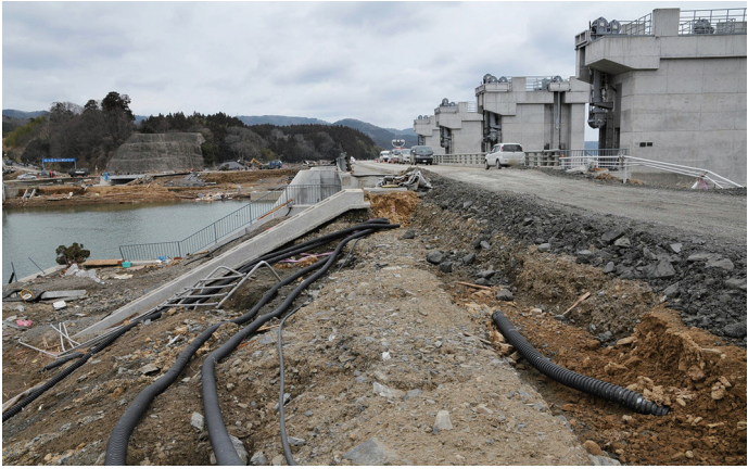
月浜第1水門付近(石巻市)
