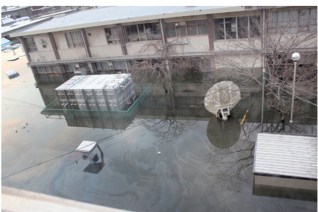
浸水した石巻合同庁舎
