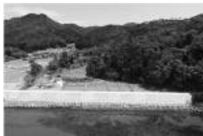
写真－8 復旧した防潮堤（石巻市十八成浜）
