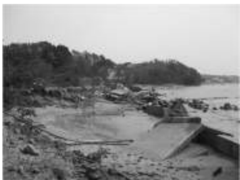
写真-4 海岸防潮堤の被害
