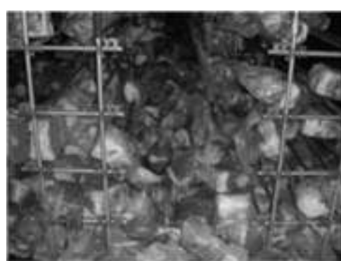
写真-5 きのこ生産施設の被害
