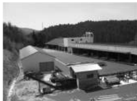
写真－10 復旧した製材工場（南三陸町）
