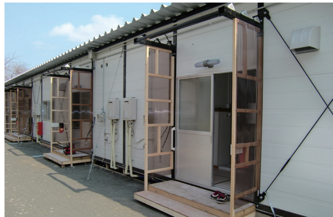
建設型応急住宅(女川町)
