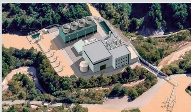
更新工事では、蒸気や熱水を地下から取り出す「地熱生産井」及び熱水を地下に戻す「地熱還元井」を新たに5本ずつ掘削するとともに、発電機やその設備を設置する建屋、冷却塔なども新しい設備を導入しました。更新後の設備は、以前よりも高効率です。
