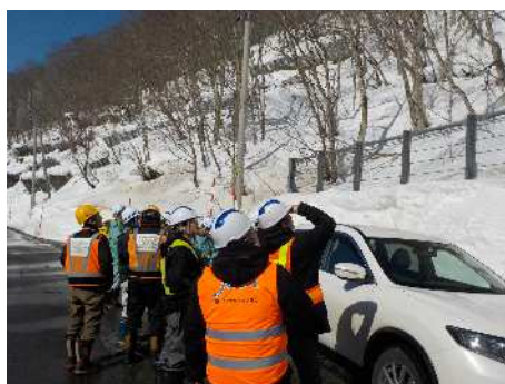
斜面点検（国道347号）
