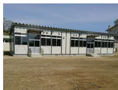
仮設校舎の設置 (小牛田高等学園実習棟)
