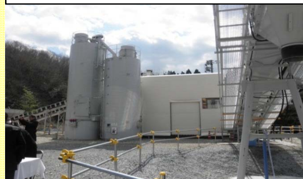
完成したプラント全景
