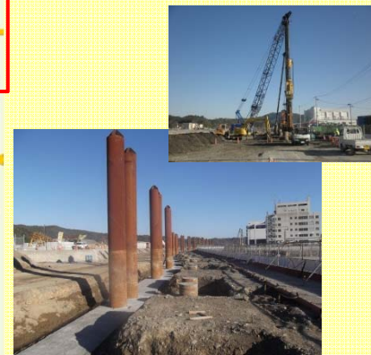
【基礎杭打込み状況】 (左図の赤囲い段階)
