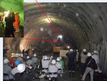
【トンネル貫通の瞬間】
