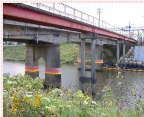
【昭和9年建設の二代日本町橋】 大川が水位周知河川に指定され、橋脚に警戒水位等の標示を設置しました。
