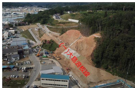
浪板道路改良工事(その2)
