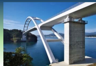
大島架橋本体工事が完了
