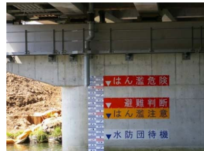
橋脚への水位表示例
